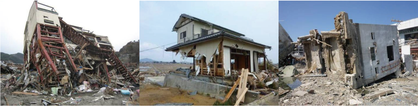
写 3-2-2 津波による被害
