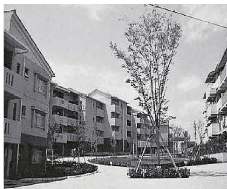
写真3-1-1 前橋市清里前原団地
